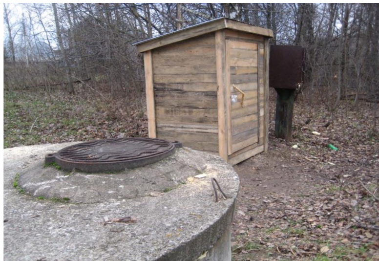
оголовок скважины и будка ЧРП
