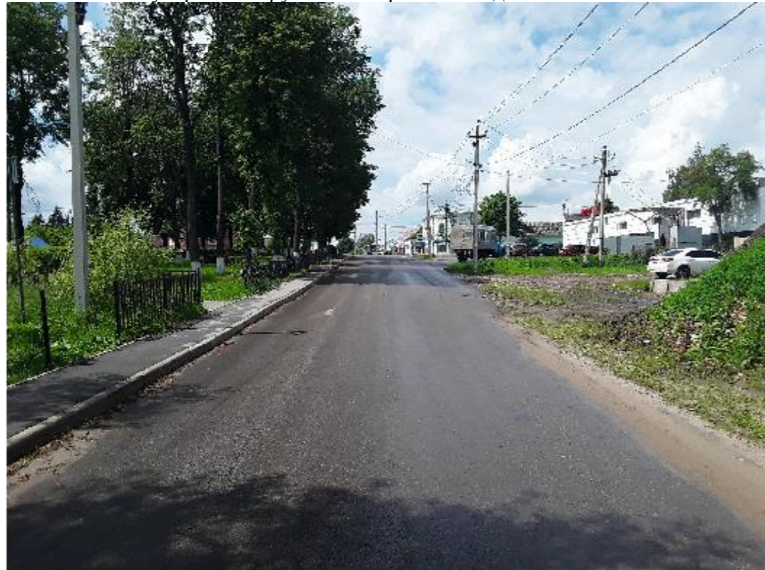
Рис. 7. Общий вид на проезжую часть над трубой
