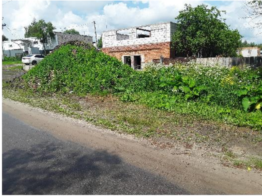
Рис. 9. Вид на проезжую часть справа
