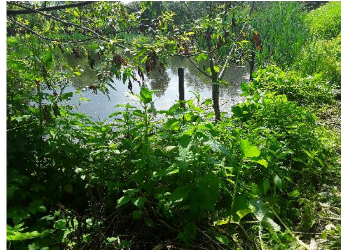
Рис. 4. Общий вид русла со стороны входного оголовка. Заращение кустарником русла входного оголовка. Отсутствие укрепления русла входного оголовка
