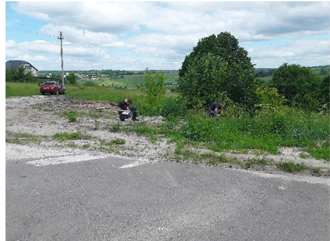
Рис. 2. Вид на проезжую часть справа
