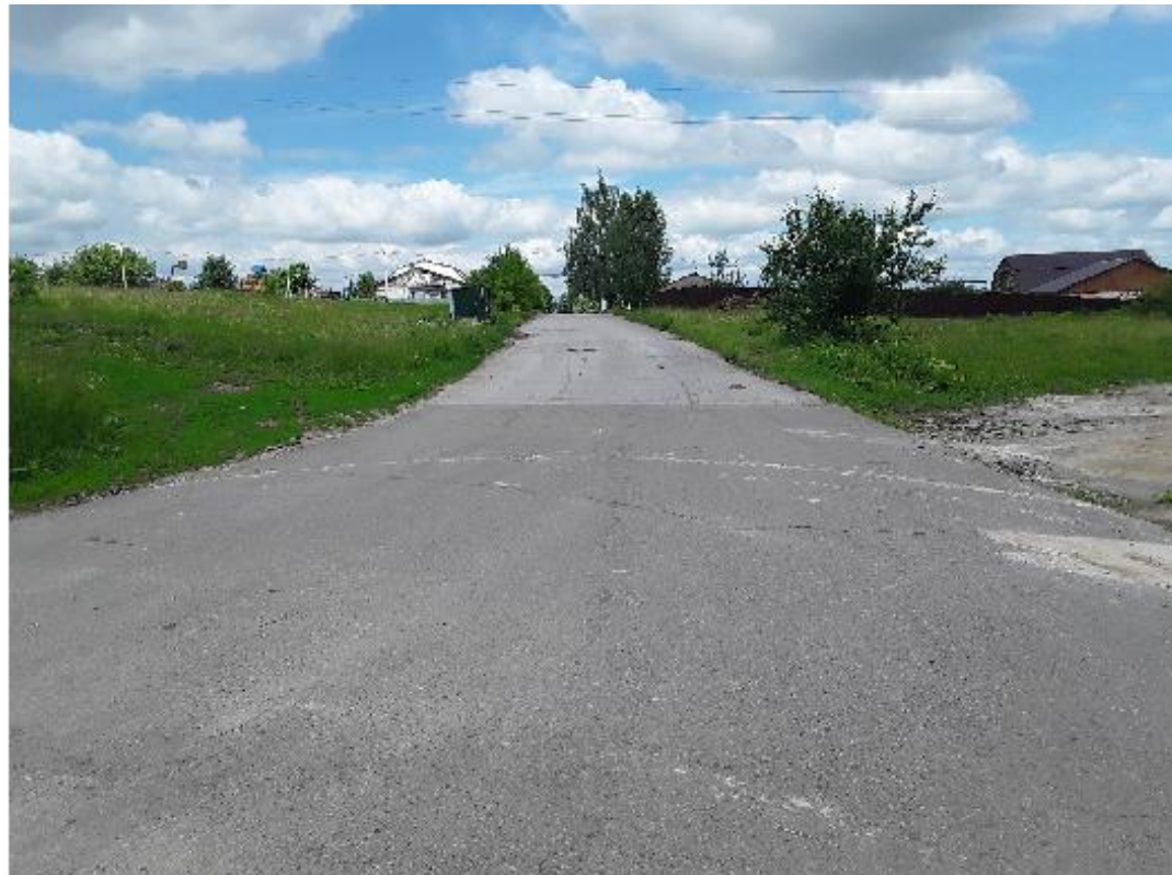
Рис. 1. Общий вид на проезжую часть над трубой
