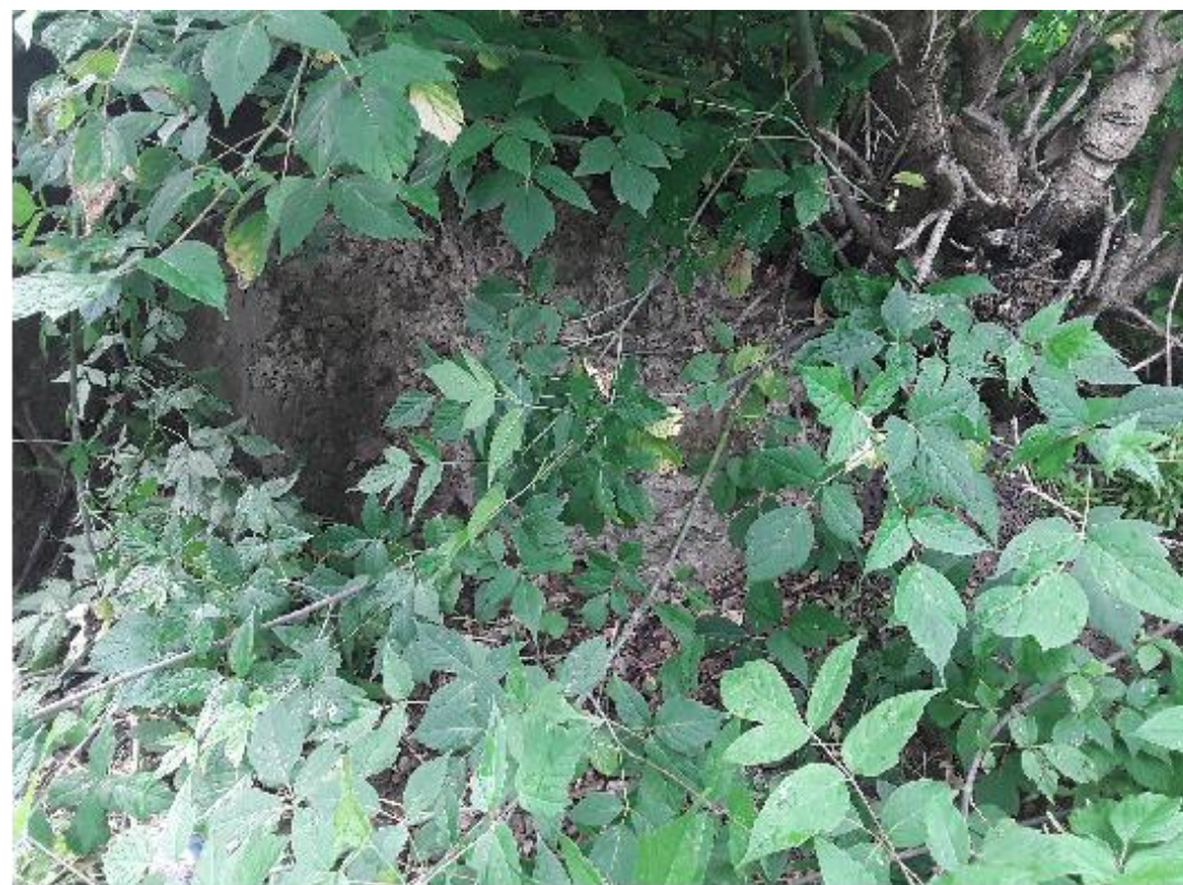
Рис. 11. Разрушение верхнего слоя бетона на откосных стенках.
