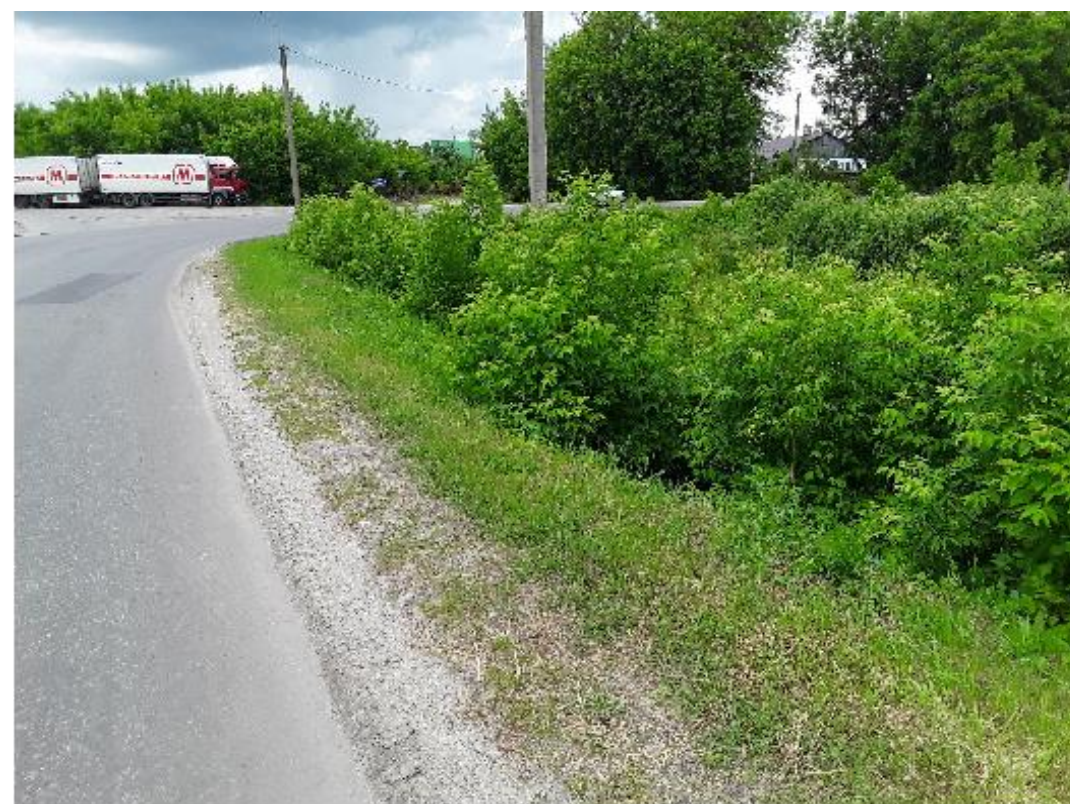
Рис. 8. Общий вид на проезжую часть справа
