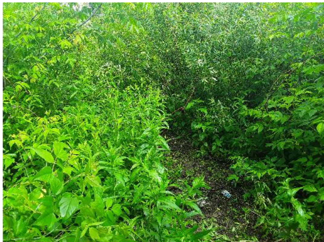
Рис. 9. Заращение деревьями и кустарником русла со стороны входного оголовка. Наличие мусора в русле со стороны входного оголовка.
