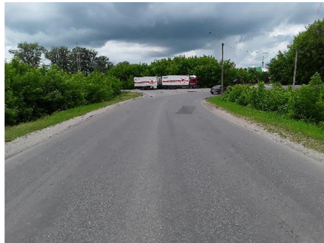
Рис. 6. Общий вид на проезжую часть над трубой
