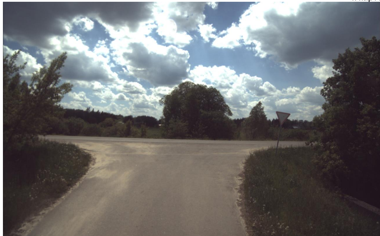
Рис. 1. Общий вид на проезжую часть над трубой
