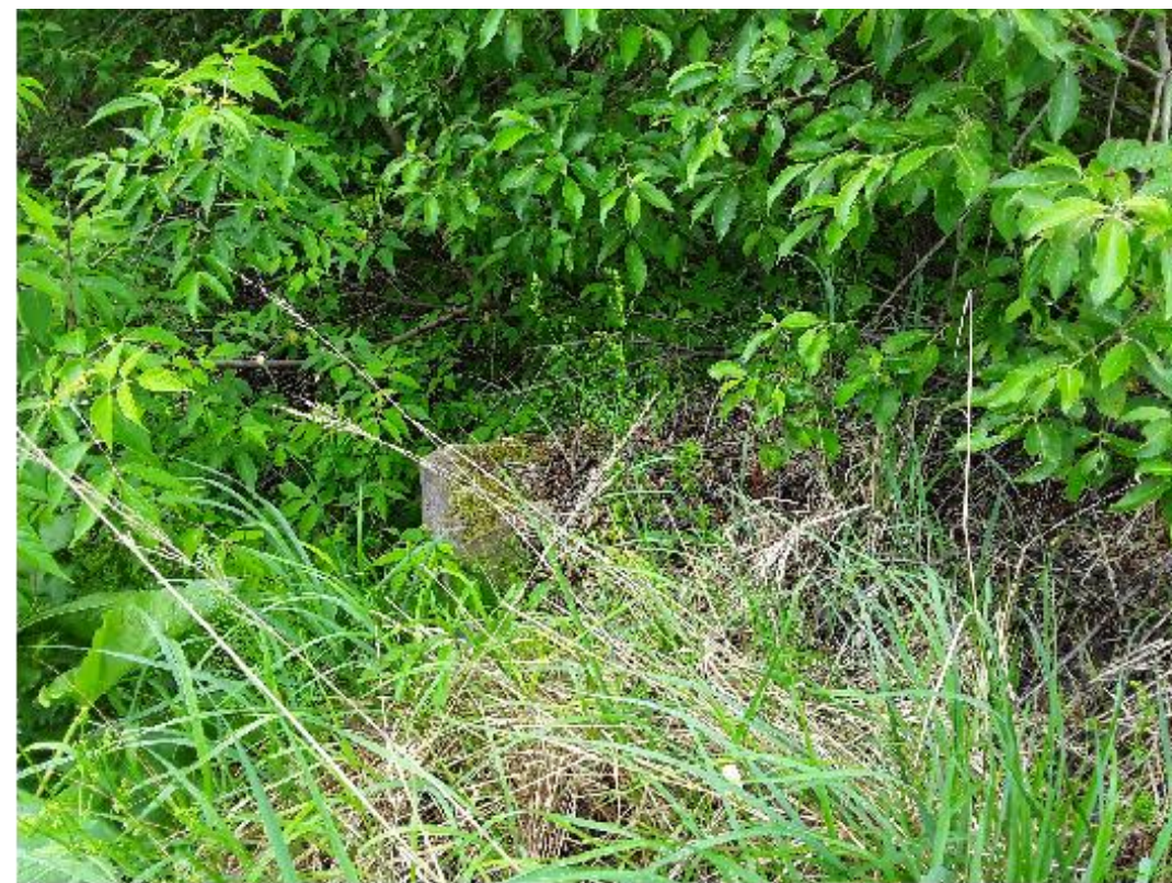
Рис. 4. Общий вид русла со стороны входного оголовка. Заращение деревьями и кустарником русла входного оголовка. Отсутствие укрепления русла входного оголовка.
