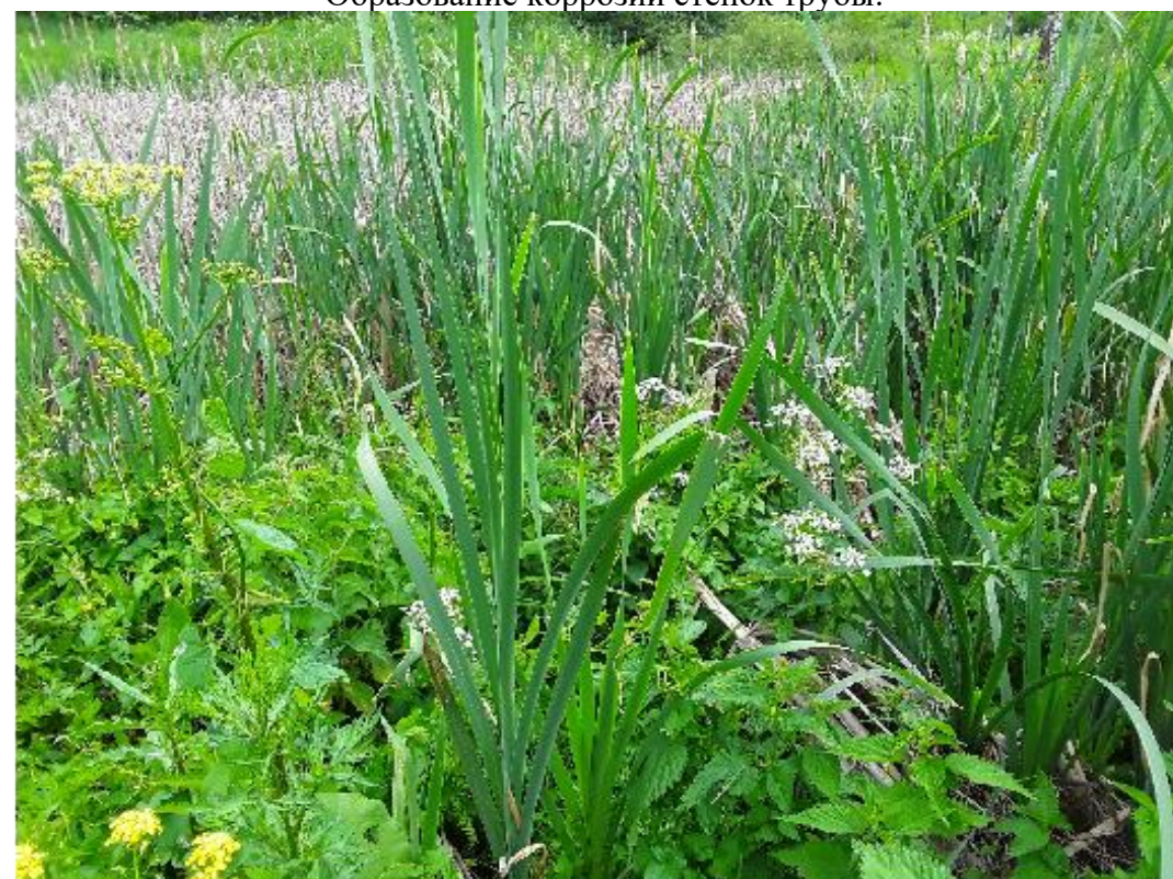
Рис. 8. Общий вид русла со стороны выходного оголовка. Пруд на выходном русле.
