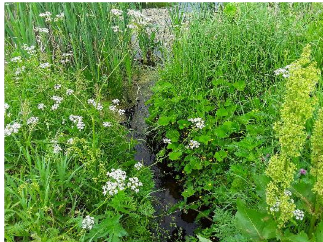
Рис. 4. Общий вид русла со стороны входного оголовка. Заращение русла входного оголовка. Отсутствие укрепления русла входного оголовка.
