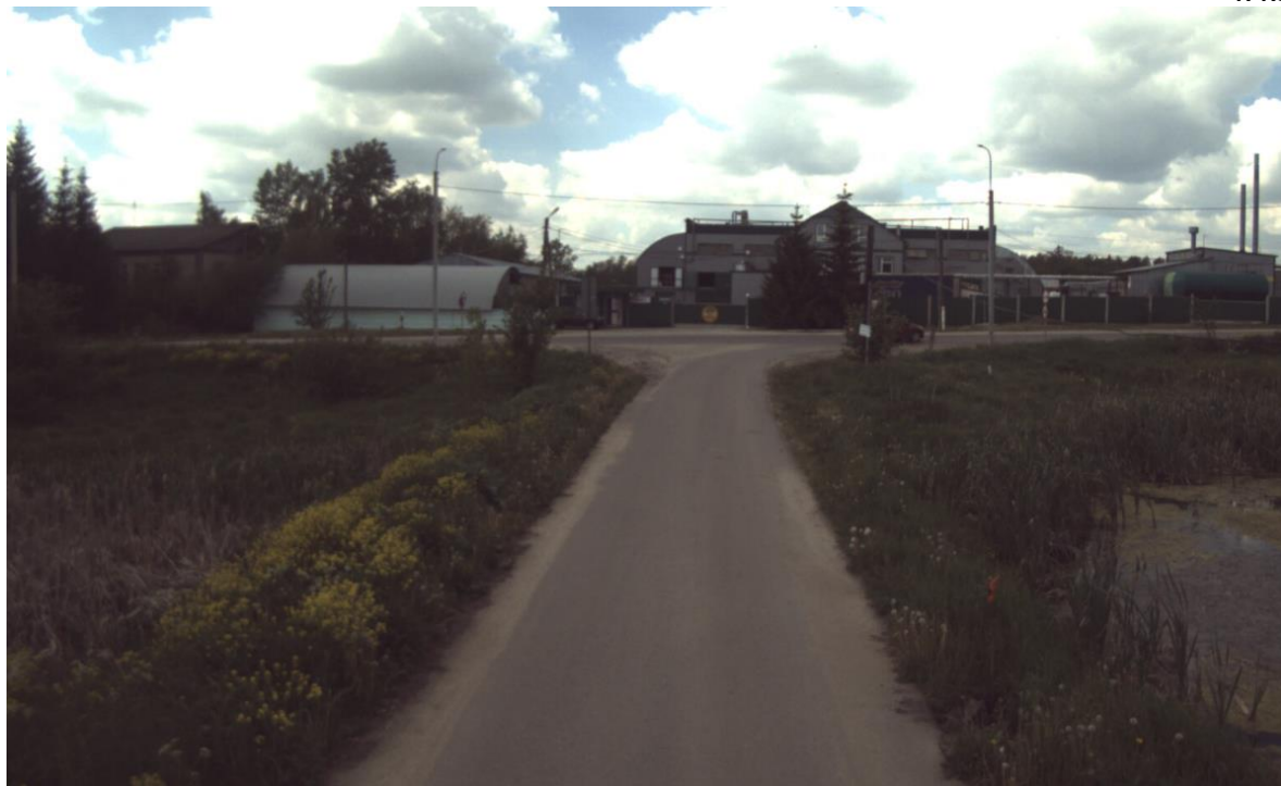
Рис. 1. Общий вид на проезжую часть
