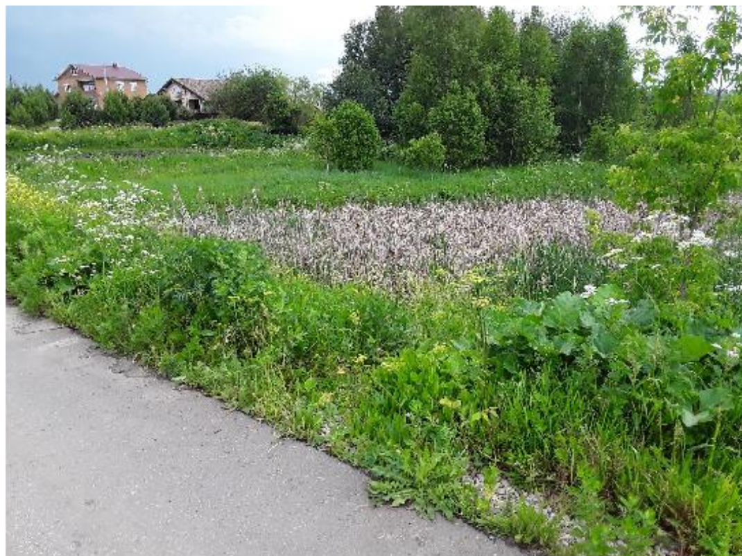
Рис. 3. Вид на проезжую часть над трубой справа
