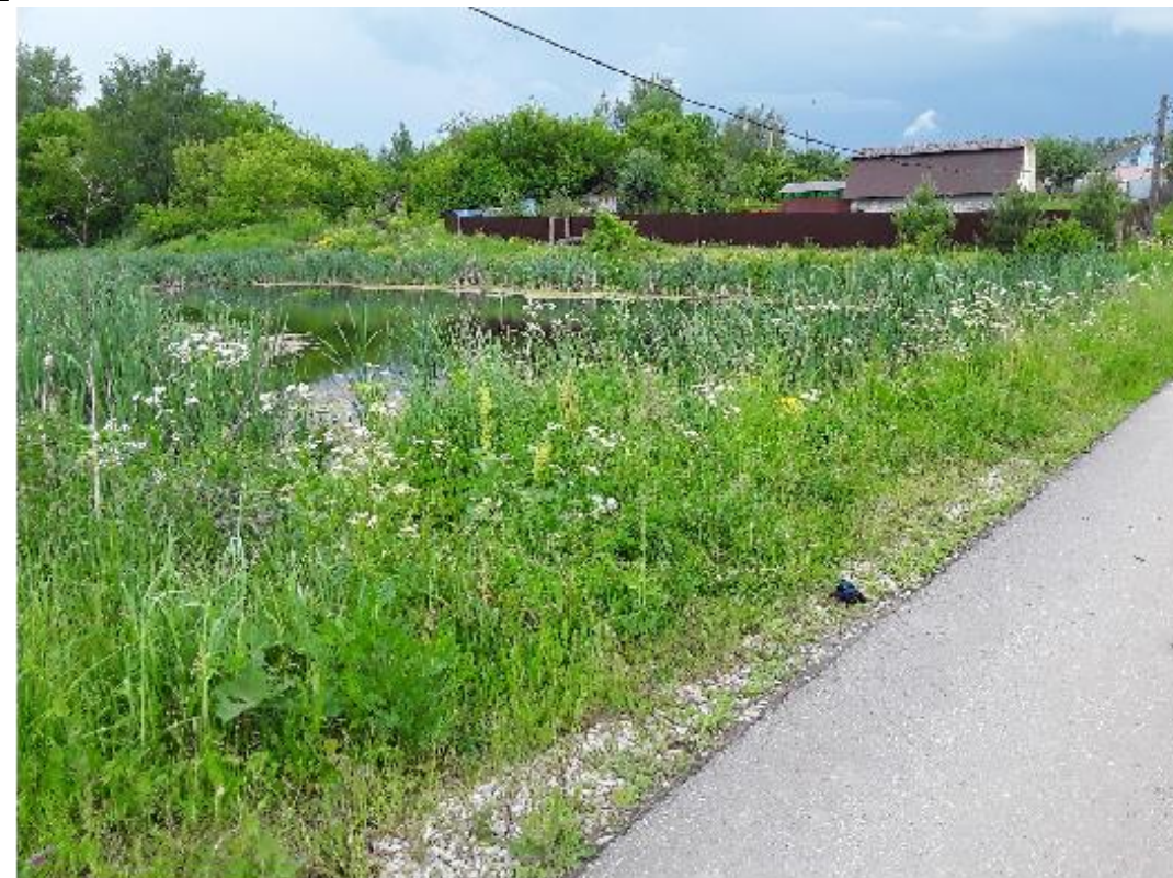
Рис. 2. Вид на проезжую часть над трубой слева
