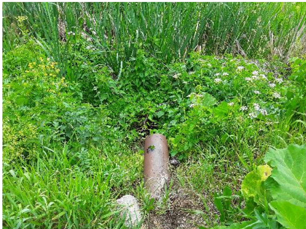
Рис. 5. Общий вид русла со стороны выходного оголовка. Заращение русла выходного оголовка. Отсутствие укрепления русла выходного оголовка.
