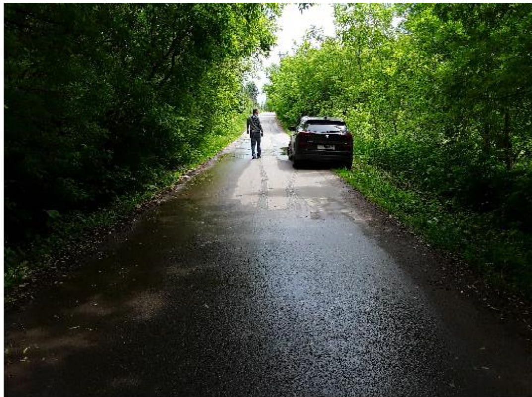
Рис. 1. Общий вид на проезжую часть над трубой.
