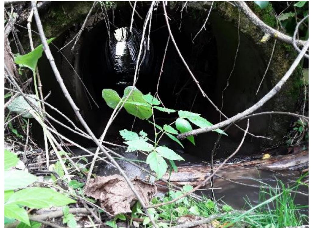
Рис. 6. Уменьшение отверстия трубы со стороны входа, заиливание.
