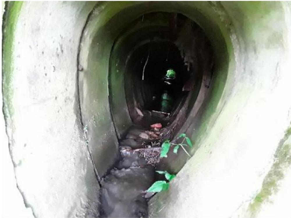
Рис. 5. Заливание лотка трубы.
