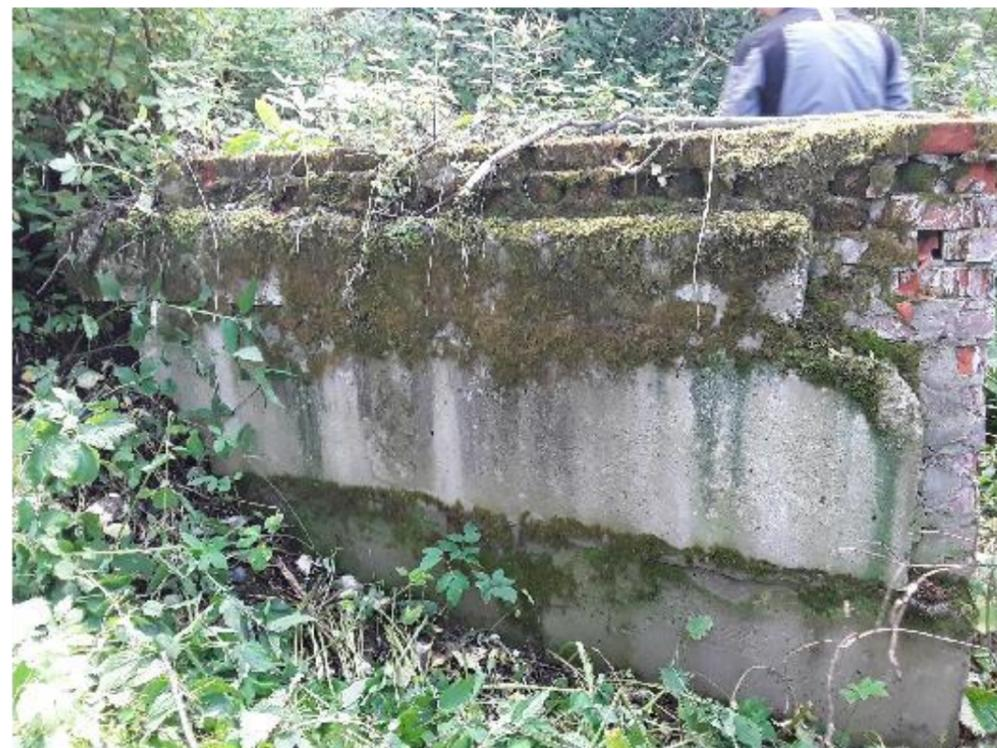
Рис. 8. Разрушение откосной стенки со стороны входного оголовка справа
