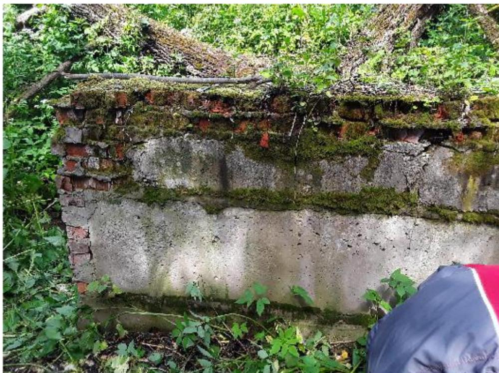
Рис. 7. Разрушение кладки откосной стенки трубы со стороны входного оголовка
