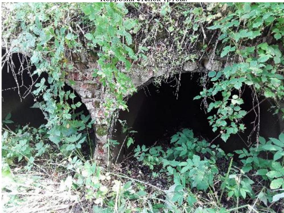
Рис. 11. Разрушение порталной стенки трубы со стороны входного оголовка.
